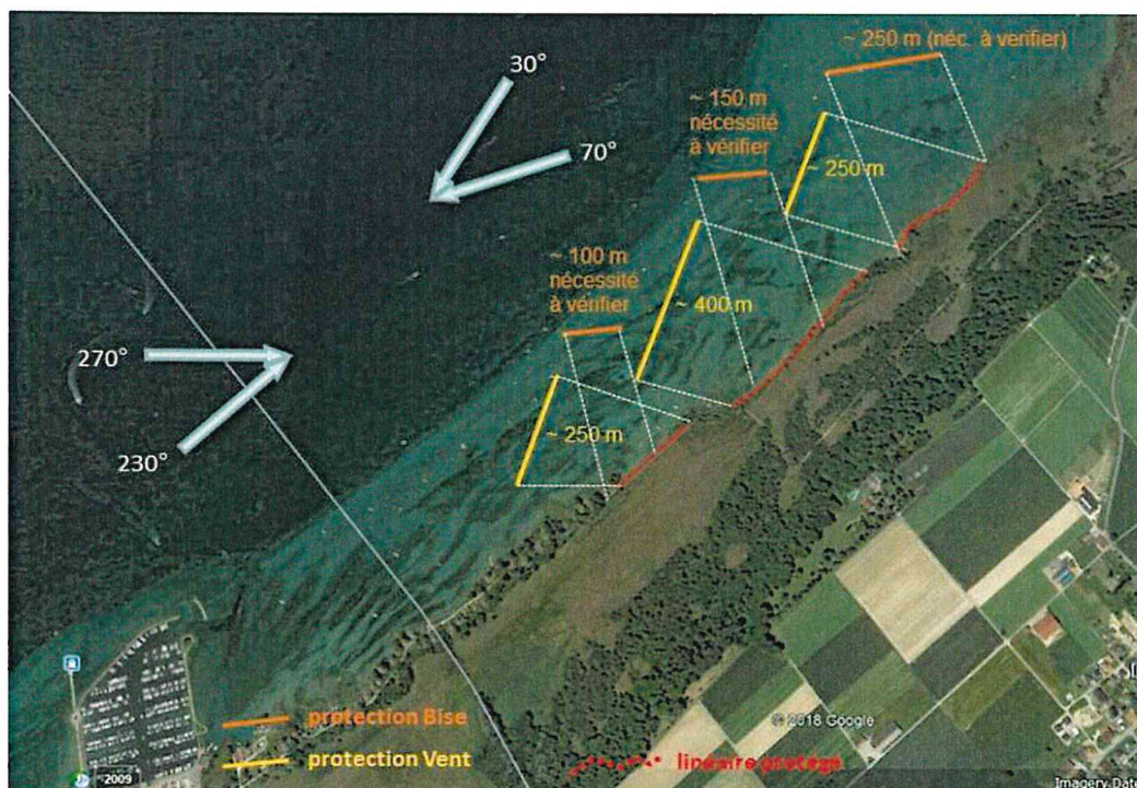
Figure 2 : Site prioritaire de lutte contre l'érosion. Site de Montbec, commune de Chabrey (VD)
